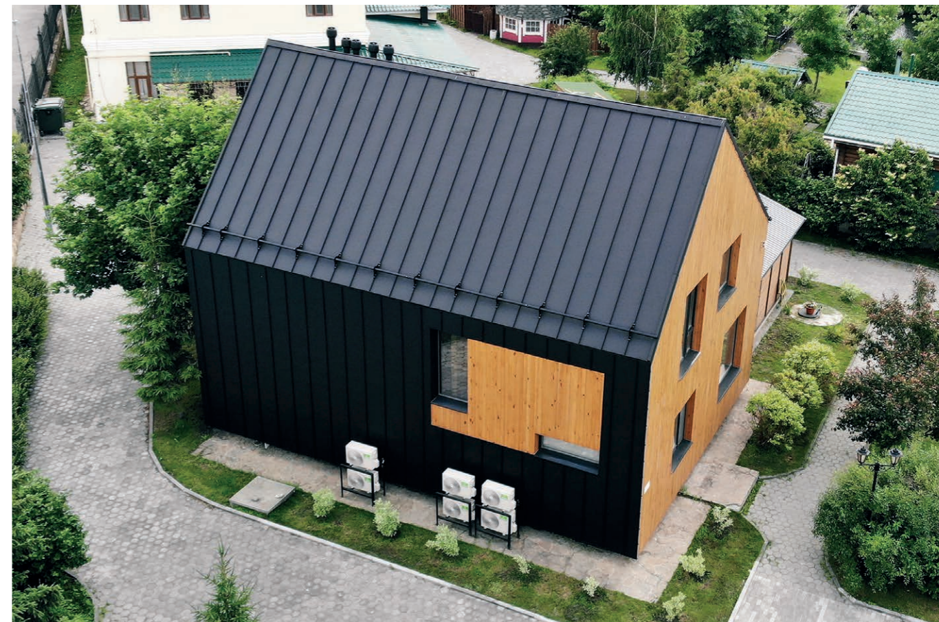
Кликфальц® Pro Drap RAL7024, снегозадержатели для фальцевой кровли Grand Line. Объект ДОМОУ
