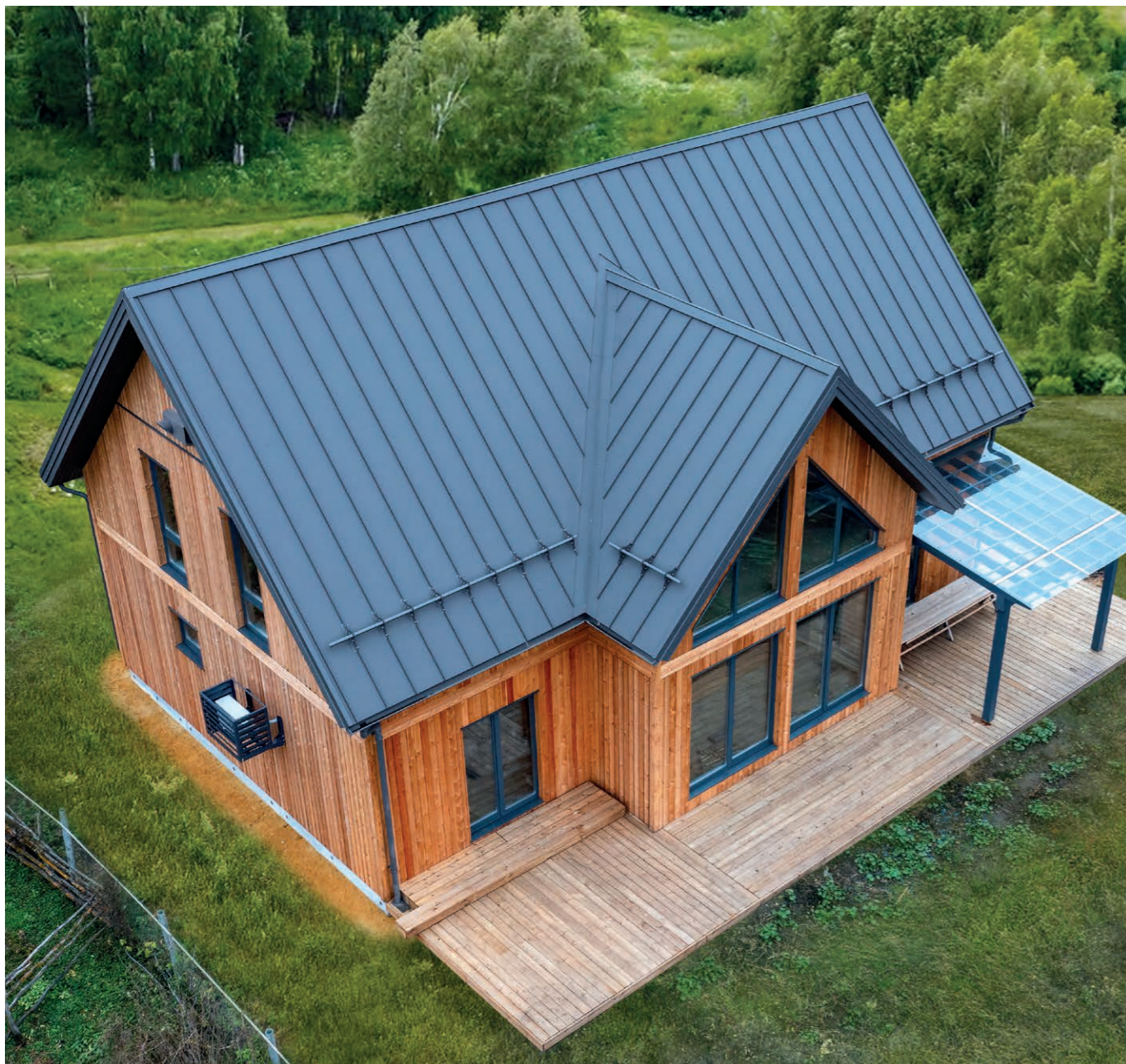
Кликфальц® Drap RAL7024, снегозадержатели для фальцевой кровли Grand Line. Объект Swedhus
