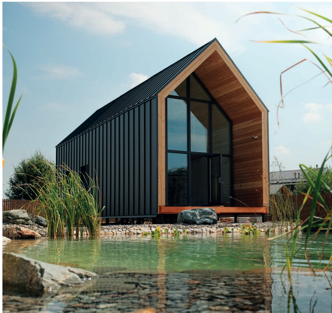
Кликфальц® Pro Rooftop Бархат RAL7024. Объект ОКprefab
