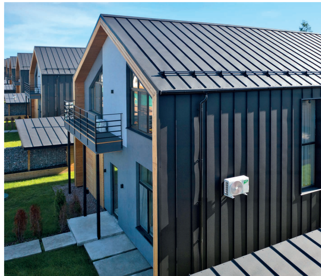
Кликфальц® Fin Drap RAL9005, водосток металлический Grand Line 125/90 мм. Объект Rempiter
