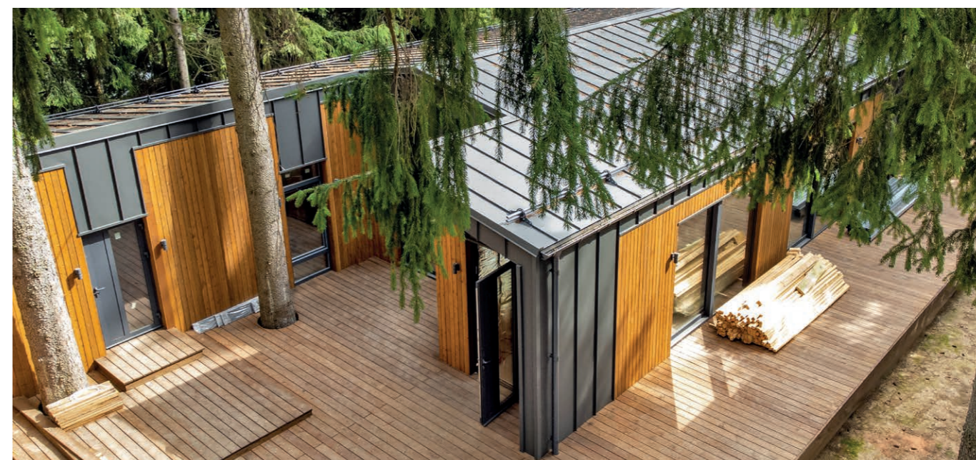
Кликфальц® Velur RAL7024, водосток металлический Grand Line 150/100 мм, снегозадержатели для фальцевой кровли Grand Line. Объект Varne
