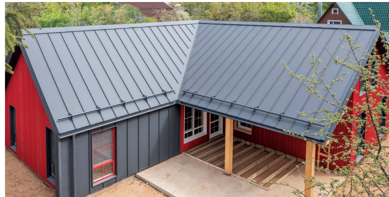
Кликфальц® Pro Satin RAL7024, водосток металлический Grand Line 125/90 мм, снегозадержатели для фальцевой кровли Grand Line. Объект Fin.House
